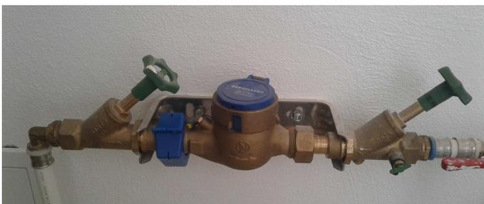
So muss die Einbauvorrichtung des Wasserzählers aussehen, damit diese vom Gemeindebediensteten getauscht werden kann.
