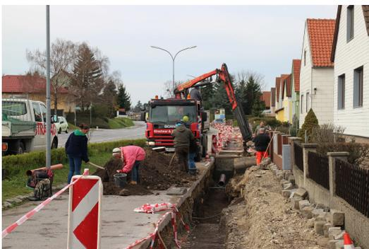
Im Bereich der Hauptstraße vis à vis des Kulturhauses wurde mit den Arbeiten zur Verbesserung der Straßenentwässerung begonnen. Auch hier mussten die Archäologen tätig werden und die Grabung begleiten. Die Untersuchungen sind noch nicht abgeschlossen. Etliche interessante römische Stücke kamen zu Tage und weitere werden in dem noch zu untersuchenden Teil
